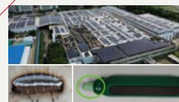
グループ最大規模となる3.48MWの太陽光発電設備を設置。また溶接の完成品検査で使用するプラスチック型のペンからチョークに置き換え年間約1.2tのごみを削減。
